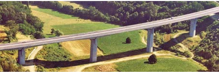
Viaduc de l'Arrêt d'Arret
