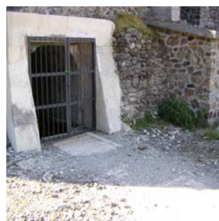
Fenêtre prise d'eau EDF
