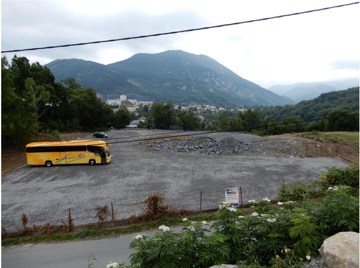
Le parking à bus non terminé, mais déjà en activité.
