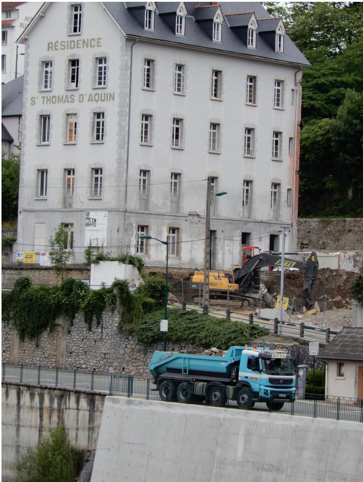
Rue du Docteur Boissarie, chantier de démolition de la résidence Saint Thomas d'Aquin. Au premier plan, le camion 32 tonnes de la société STTL plein de gravats, prêt pour aller benner son contenu sur les terrains de la SARL Hôtel Angelic ayant pour gérant Monsieur Alain Abadie.
