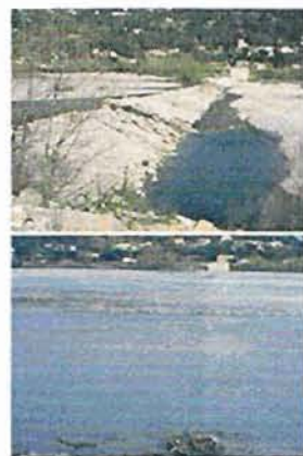
Seuil du Var avant et après travaux, Conseil départemental 06
